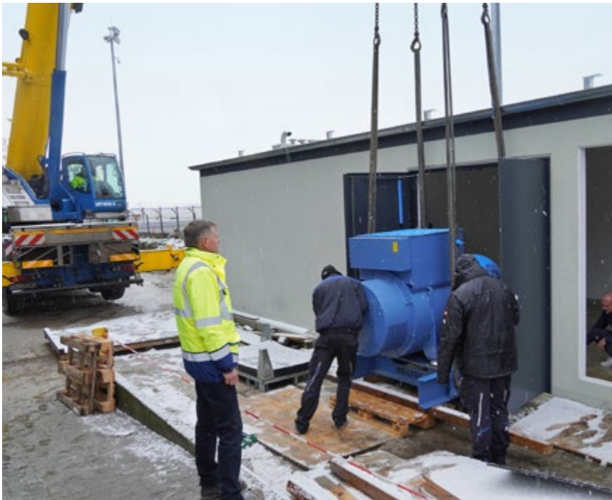
Im November wurde der tonnenschwere Generator der Netzersatzanlage unter den Augen von Christoph Schelenz (li.) und Hans-Gerd Thormeier (re.) mit einem Spezialkran in das neue Versorgungsgebäude verladen. In Kürze wird das Dieselaggregat zur Notstromversorgung in Betrieb genommen.
