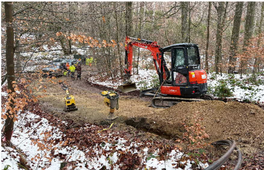
Das Loch für die nächste Bohrung wurde gegraben. Fotos: Bleona Percuku/DFS
