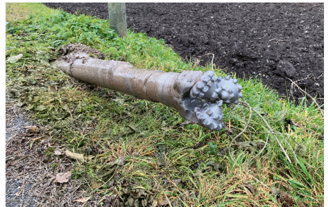
Der Bohrkopf dringt am geplanten Ziel aus der Erde.
