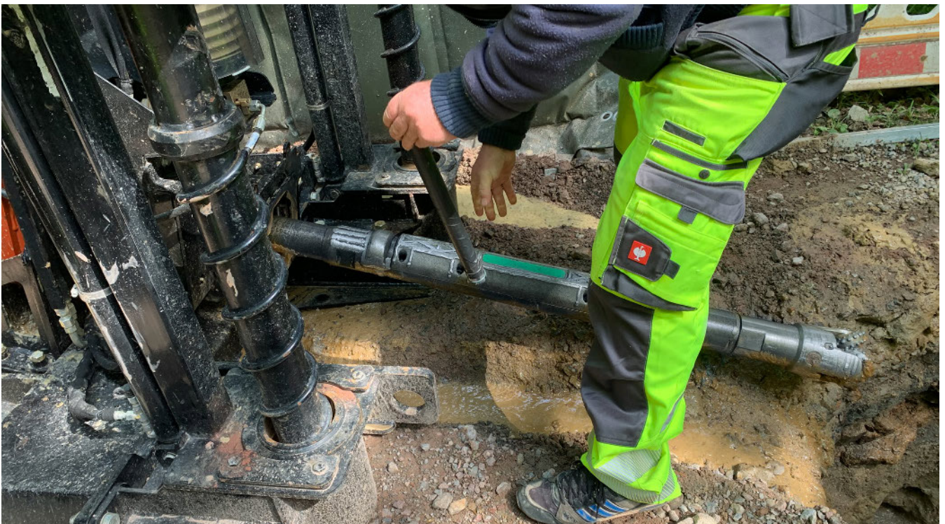
Der Bohrer wird für den nächsten Einsatz vorbereitet.
