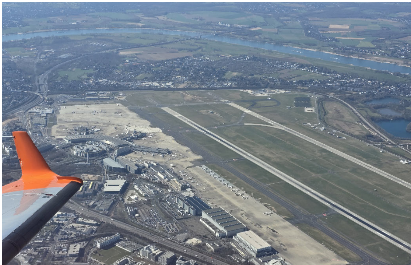
Das neue DVOR/DME am Flughafen Düsseldorf (oben im Bild zwischen den Pisten) vom Messflugzeug aus fotografiert: Diese Anlagen sind beim Ein-, An- und Abflug unverzichtbar als Backup. Foto: DFS
