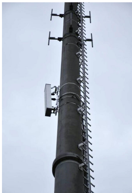
Abbildung 4: Zusätzliche L-Band-Antenne an der DFS Funkstelle Stuttgart-Berkheim.
