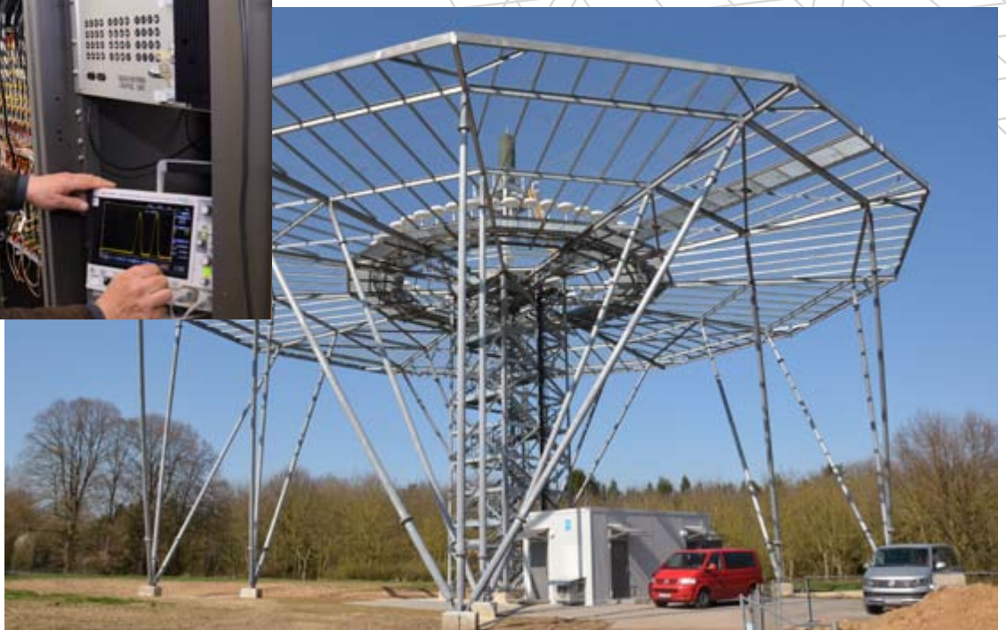
Markus Handschuh und Thomas Tretbar (von links) messen mit einem Oszilloskop an der Control Unit die Leistung der TACAN-Antenne der Nörvenicher Anlage. Bilder: H. Matthies (2)
