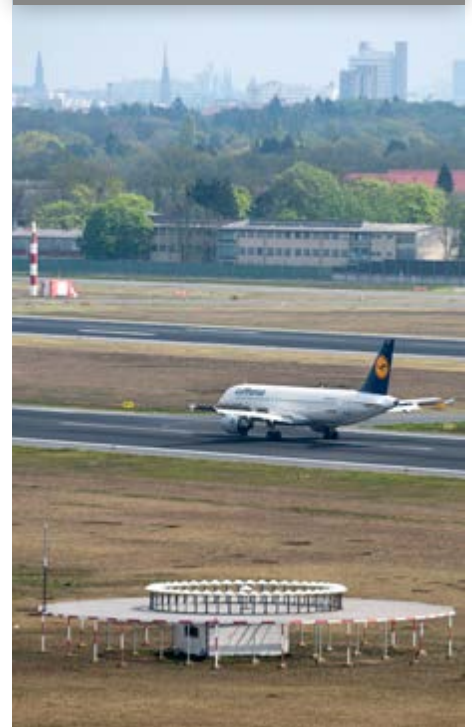
Navigation von heute: Doppler-UKW-Drehfunkfeuer mit einer Entfernungsmessausrüstung (DME) in Berlin Tegel.
