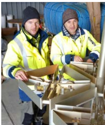
René Wagner (links) und Thomas Langer bauen die neue VOR-Antenne zusammen. Foto: Andreas Lubosch
