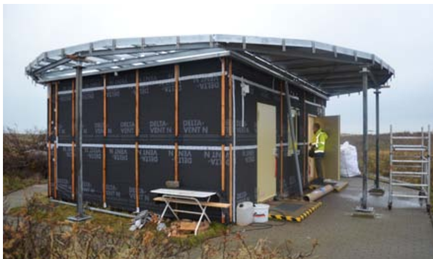
Die Stahlkonstruktion trägt später Antenne und Radome. Fotos: Holger Matthies
