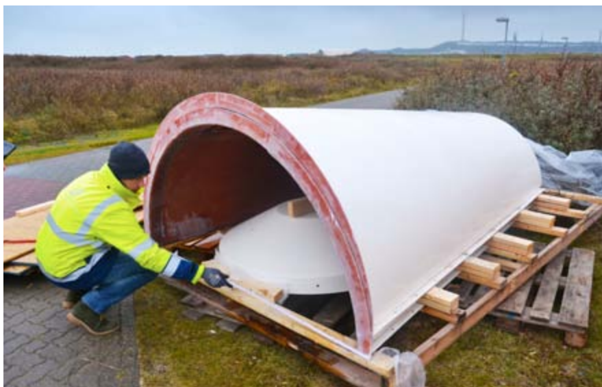
Flugsicherungsingenieur René Wagner vermisst das Radom, die Schutzhülle für die Antenne.
