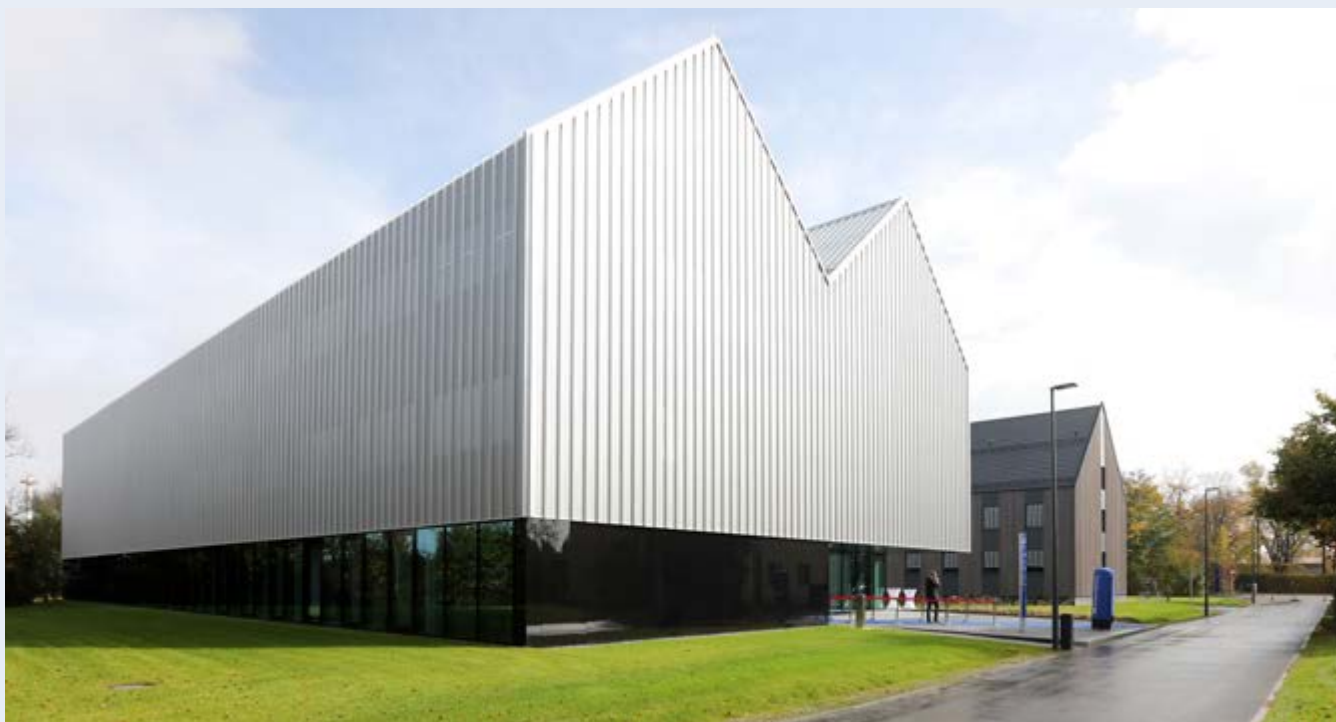
Das neue Schulungszentrum in Kaufbeuren. Im Hintergrund ist eines der beiden sanierten Unterkunftsgebäude zu sehen.
