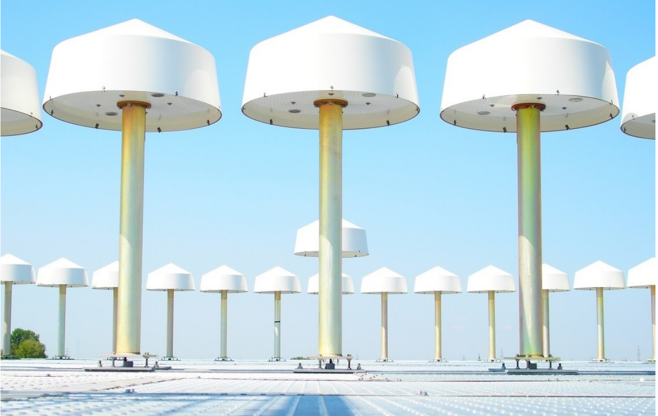
Der Schutzbereich rund um Doppler-Drehfunkfeuer wie die DVOR Ottersberg wurde von 15 auf sieben Kilometer verkleinert. (Foto: DFS)
